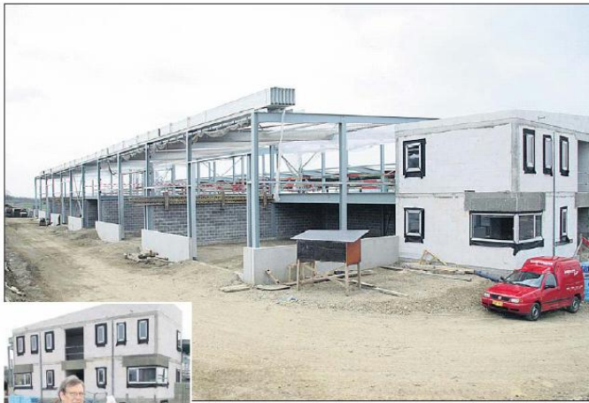
Die Bauarbeiten des ersten luxemburgischen Handwerkerhofs in der Industriezone „Triangle Vert“ laufen nach Plan. (FOTOS: MARC SCHOENTGEN)
